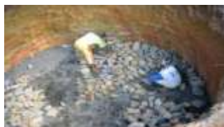
Gambar 2 Proses Penggalian Pembuatan Digester
