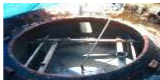
Gambar 3 Proses Penyemenan Digester
